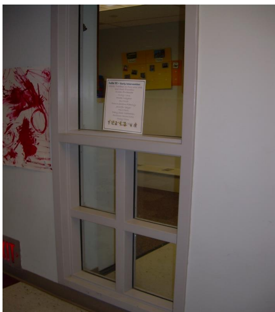
Figura 7: Janela de corredor da PSD.
